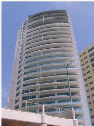
Obra en proceso
