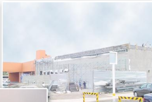
Obra en proceso
