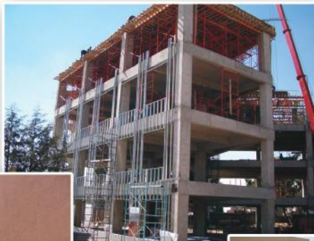
Obra en proceso
