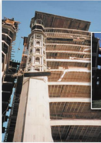
Obra en proceso
