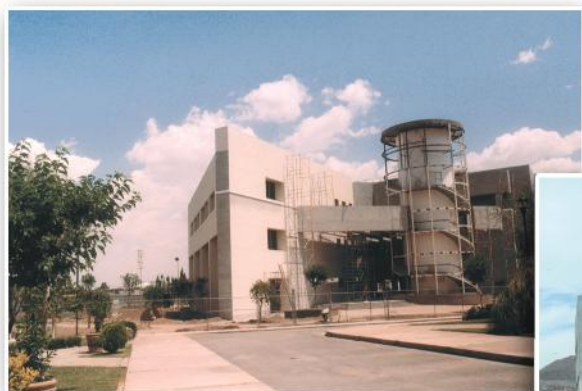
Obra en proceso
